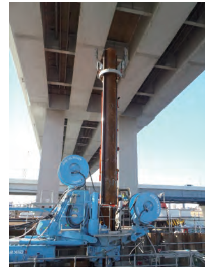
鋼管矢板圧入
